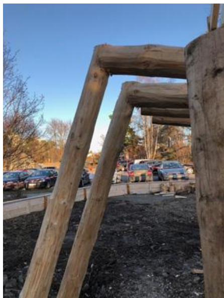
Stockarna som fästs under mark tjäras först för att motstå röta och därmed öka livslängden.
