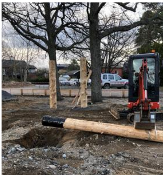
Stockarna som fästs under mark tjäras först för att motstå röta och därmed öka livslängden.
