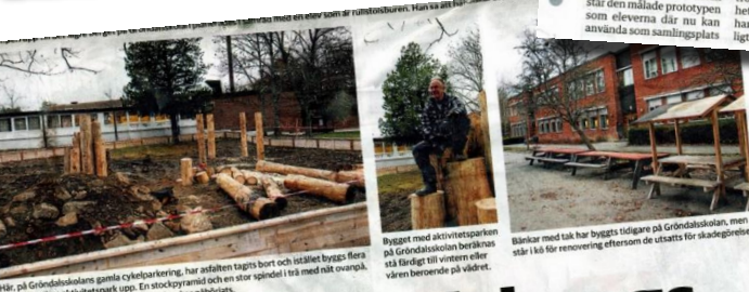
Här, på Gröndalsskolans gamla cykelparkering, har de vuxna tagits bort och istället byggts flera stationer till en aktivitetspark upp. En stockpenn och en stor spindel i trä med rikt utvalg, som eleverna kan klättra upp i från baksidan, har påbörjats.
