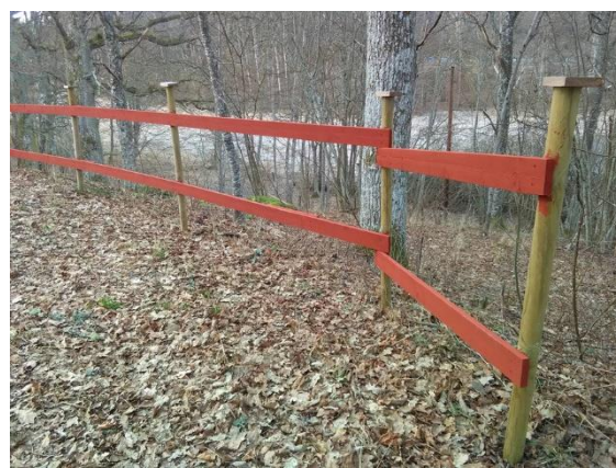
En arbetstränande person och en APL-elev byggde under våren ett nytt staket då det gamla förmultnat. Materialet bekostades av Naturskolan genom försäljning av kurser.
