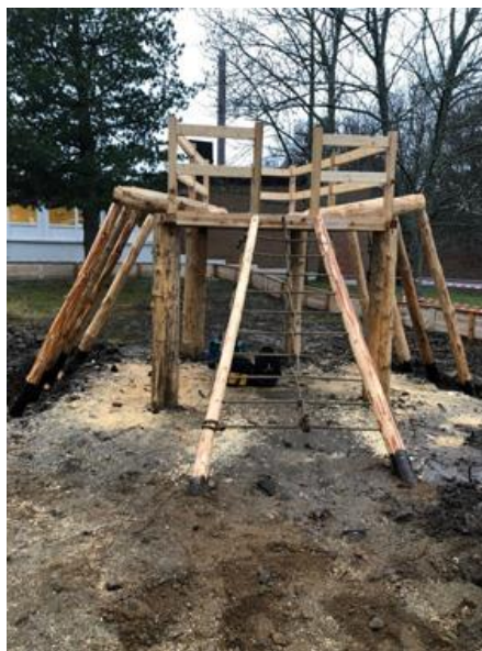
En spindel tar form. Nätet utgörs av hamparep. Staketet på spindelns rygg är i enlighet med EU-normerna.
