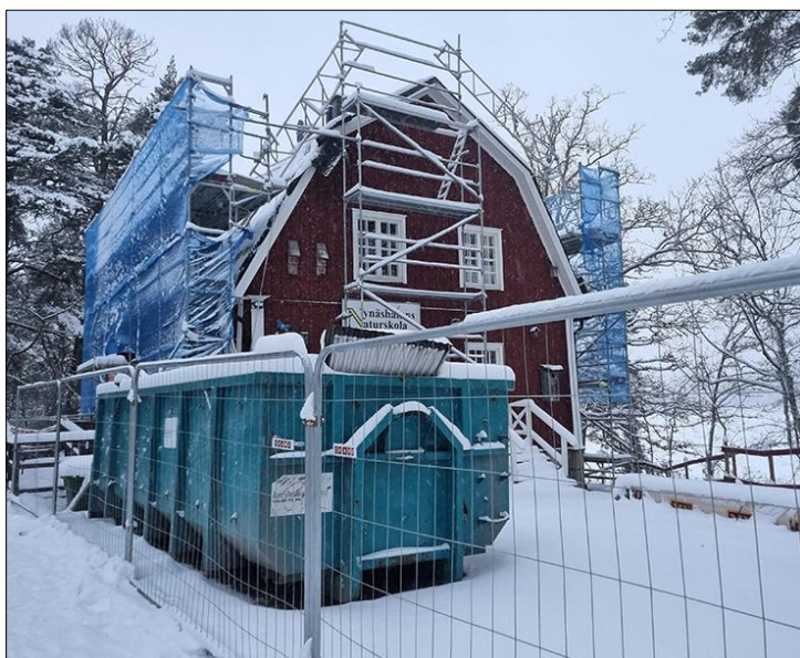
I november påbörjades arbetet med att renovera taket på Naturskolan. Bland annat på grund av vädret försenades arbetet som fortsatte in i det nya året.
