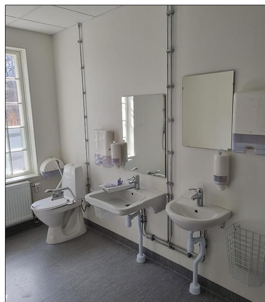
Den nya tillgänglighetsanpassade toaletten som förut var ett kontor.
