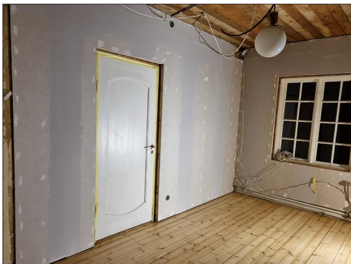
Ett rum på övervåningen renoverades för att bli nytt kontor och på så vis ge plats åt en tillgänglighetsanpassad toalett (RWC) på entréväningen.
