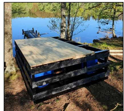
En flytbrygga tillverkades av lärmiljöutvecklaren Janne för att ersätta den gamla fasta bryggan som inte fyller sin funktion när vattennivån växlar kraftigt.
