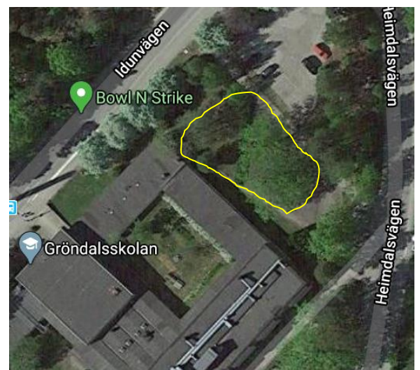
På en del av cykelparkeringen på norra delen av skolgården påbörjades arbetet med en aktivitetspark under hösten.
