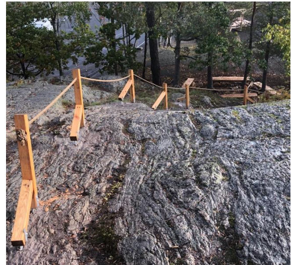
Tjärat hamparep fästes i stolparna som fastsatts på Gröndalsskolans berg. Både elever och lärare kan nu ta hjälp av repet för att ta sig upp på berget.
